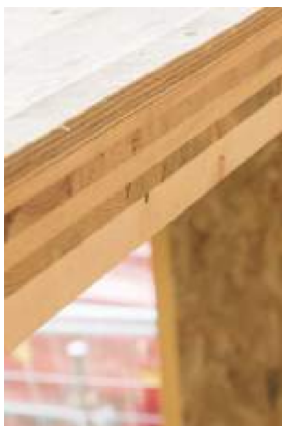
Face pin non-visible avec bandes de couture en Pin Non-visible Pine face with pine seaming strips
