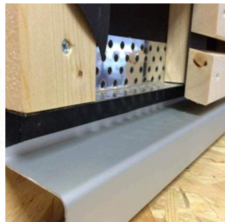
Figure 8- Détail en pied de revêtement extérieur
