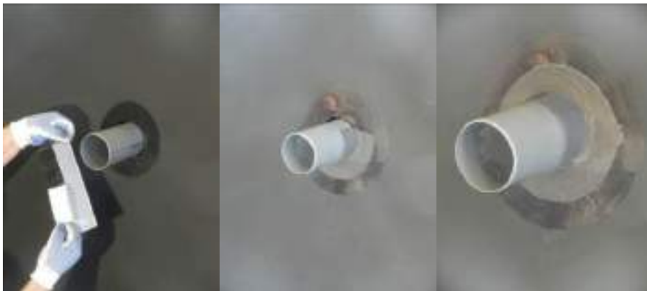
Figure 15 – Pas à pas pour la jonction d'éléments traversants (application du primaire + des 2 demi-bande de DELTA FLEX BAND
