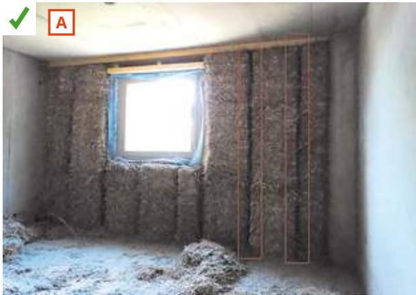
Diminution de la profondeur des montants. ©AQC-2015
