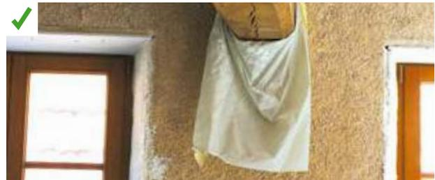
Couverture du bois apparent avec un plastique lors d'un remplissage en béton de chanvre. ©AQC-2015
