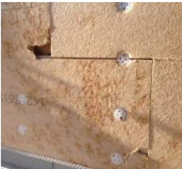
23. 24. Mauvaise mise en œuvre : plaques abîmées - plaques non jointives - fixations dans les joints - nombre de fixations non conformes -...
