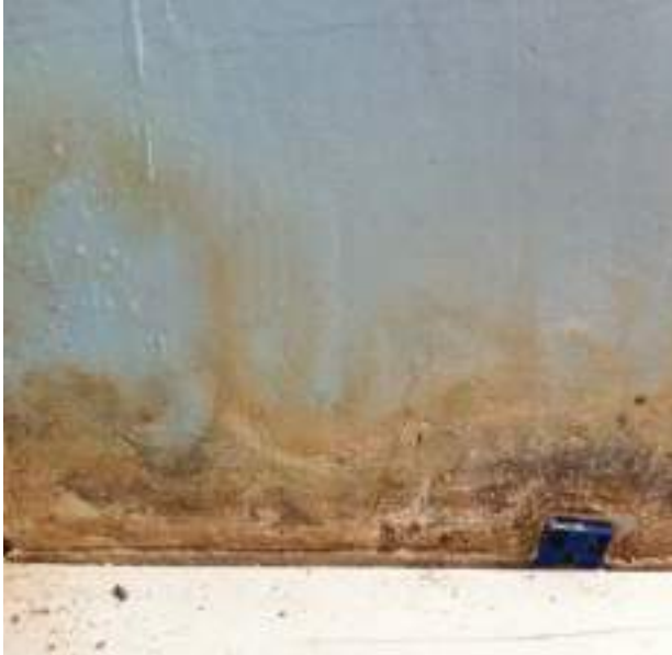
11. 12. Développement de moisissures et décollement du revêtement suite à mise en œuvre de matériaux inadaptés étanches à la vapeur d'eau, type peinture à base de liants synthétiques, sur un mur exposé
