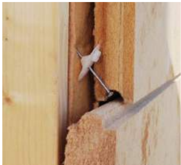
23. 24. Mauvaise mise en œuvre : plaques abîmées - plaques non jointives - fixations dans les joints - nombre de fixations non conformes -...
