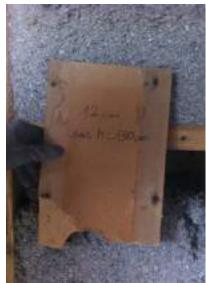
26. 27. Tassement de la ouate de cellulose dans les caissons verticaux, mauvaise mise en œuvre
