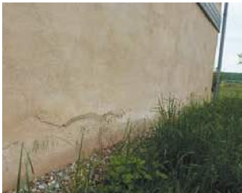
1. Remontées capillaires (non-respect des Règles professionnelles)
