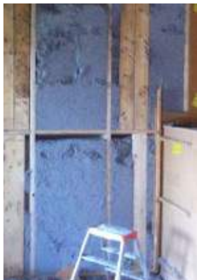
26. 27. Tassement de la ouate de cellulose dans les caissons verticaux, mauvaise mise en œuvre
