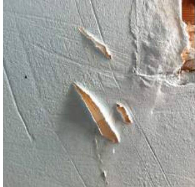
11. 12. Développement de moisissures et décollement du revêtement suite à mise en œuvre de matériaux inadaptés étanches à la vapeur d'eau, type peinture à base de liants synthétiques, sur un mur exposé
