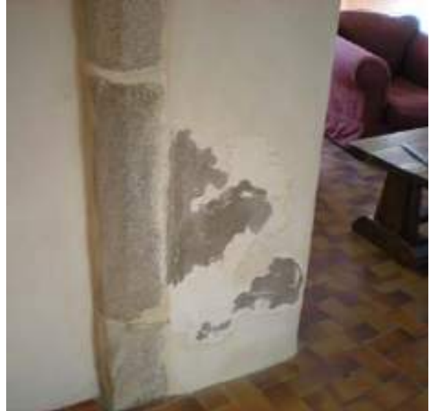
9. 10. Développement de moisissures suite à mise en œuvre de matériaux inadaptés étanches à la vapeur d'eau : enduit extérieur et peinture intérieure
