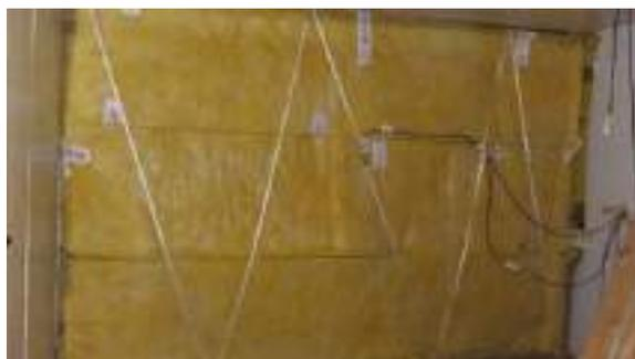
Figure 5 : Montage d'un mur sans présence d'ossature
