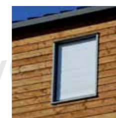
Bardage bois sans finition : après rénovation par « dégriseur »
