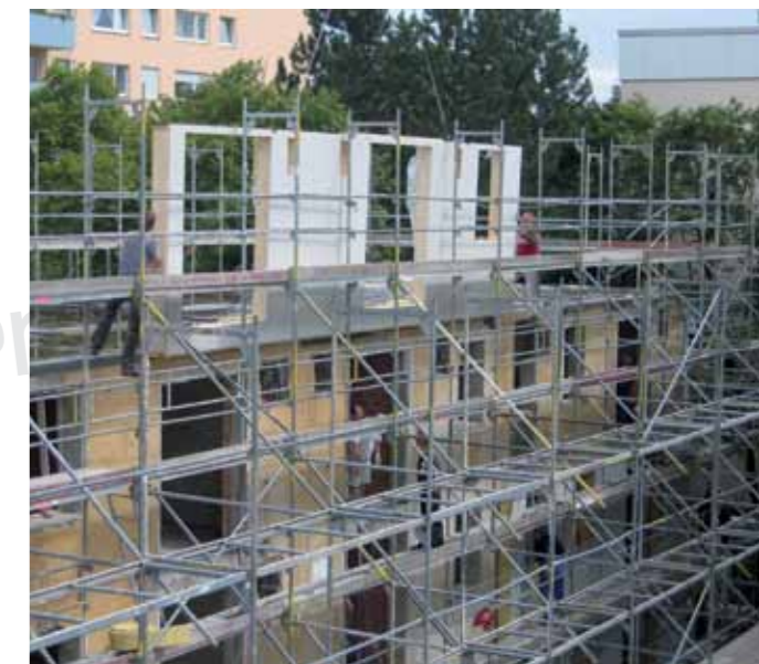
Logements en court de rénovation à Munich. Architecte : Florian Lichtblau
