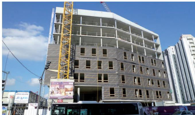
Les façades bois permettent d'excellents niveaux d'isolement aux bruits extérieurs, en utilisant le principe masse ressort masse associé à une désolidarisation de la contre-cloison intérieure.
