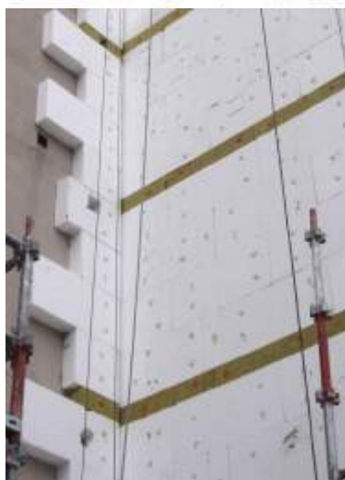
Figure 2 : protection incendie par bandes filantes incombustibles (crédit : [5])
