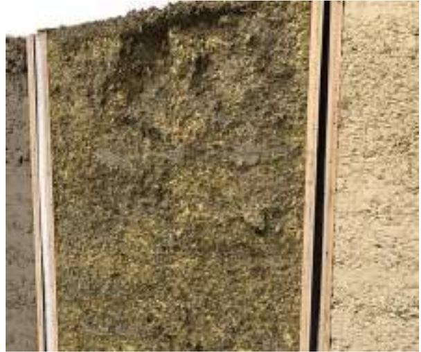
Photo 4 : béton de chanvre non homogène avec décollement ponctuel.
