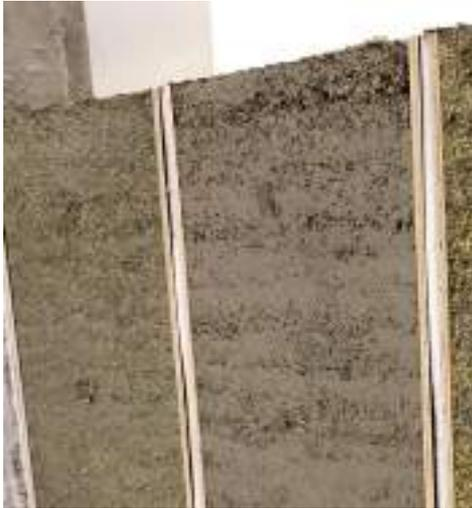
Photo 3 : béton de chanvre homogène sur sa surface.
