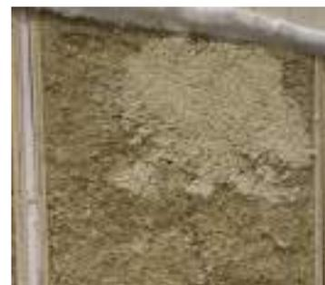
Photo 7 : béton de chanvre en fin de reprise avec rebouchage de la partie décollée.
