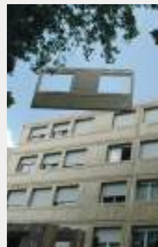
Levage des panneaux.
