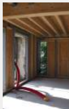
Ossature bois intérieure.
