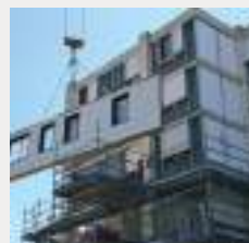
Levage des façades autoporteuses.
