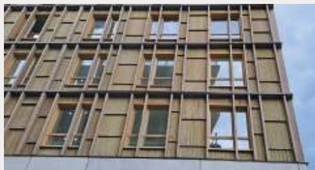
Façade ossature bois avec déflecteurs sur un immeuble d'habitation de 3 ème famille
