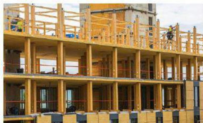
Figure 6 : Structure poteaux-poutres avec planchers en CLT et façade en ossature bois (FOB) – source Integral Bois System
