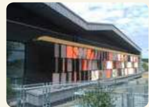
Maître d'ouvrage : FFB Compiègne
